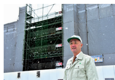
災害復興住宅建設現場
