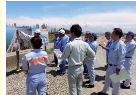
北上運河復旧現場視察
