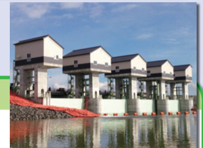
長沼ダム水門（2014年5月竣工時）
