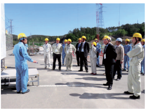
女川原発の現状を視察（防潮堤建設現場説明）
