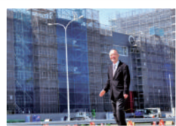
石巻市 建設中の魚市場
